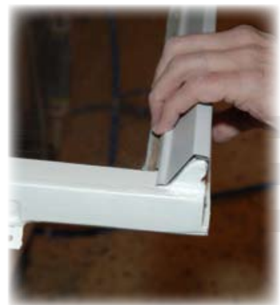
Droppnåsan skyddas med ventilerad plåt- skoning
