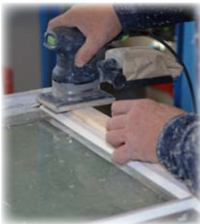
Eventuell träkomplettering, spackling och slipning
